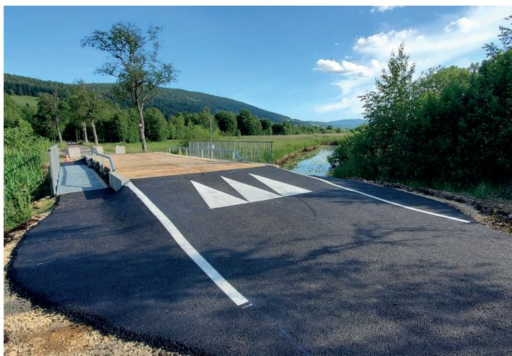
Le pont de la Planche Paget (fermé par mesure de précaution) a été rénové entièrement. Une nouvelle structure a été mise en place au-dessus l'ancien pont pour permettre la réouverture de cette route.
