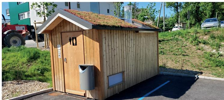
Depuis la fin de l'hiver, des toilettes sèches écologiques sont en service sur le parking du Faubourg. Dotées d'un toit végétalisé pour mieux s'intégrer dans l'environnement, elles fonctionnent grâce à la technique du lombricompostage qui permet d'éviter l'utilisation d'eau. Pas d'odeur, pas d'eau, pas d'assainissement...
