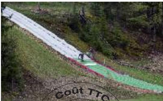
La dernière rénovation du tremplin datait de 1994. Depuis, le plancher en bois sous le plastique de la réception a vieilli, la sécurité des sauteurs en cas de chute n'était plus vraiment assurée et la fixation des ballets plastique était devenue aléatoire.
